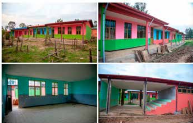
2022 Lavori per la realizzazione della scuola primaria a Shebraber
