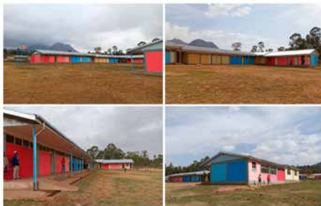
2019 Costruzione di una scuola elementare ad Abuna
