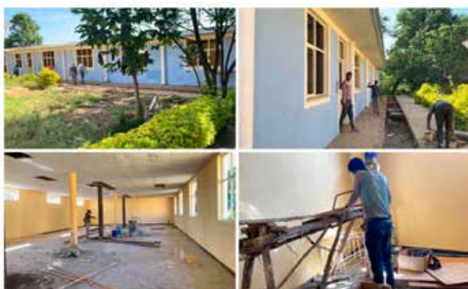
2023 Costruzione di una struttura per bambini denutriti all'interno del Centro di accoglienza di Areka grazie al sostegno di Strawberry Fields Onlus
