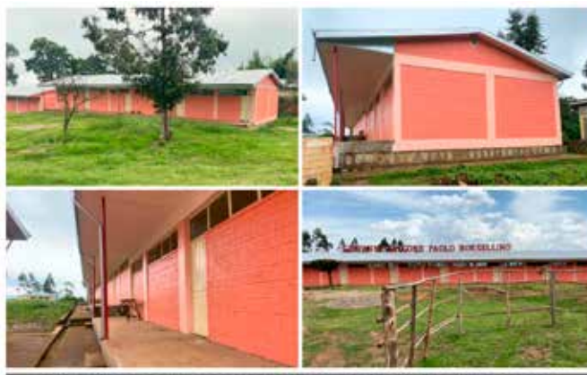
2021 Prossima alla conclusione la costruzione della scuola primaria Falcone e Borsellino a Berkoncio
