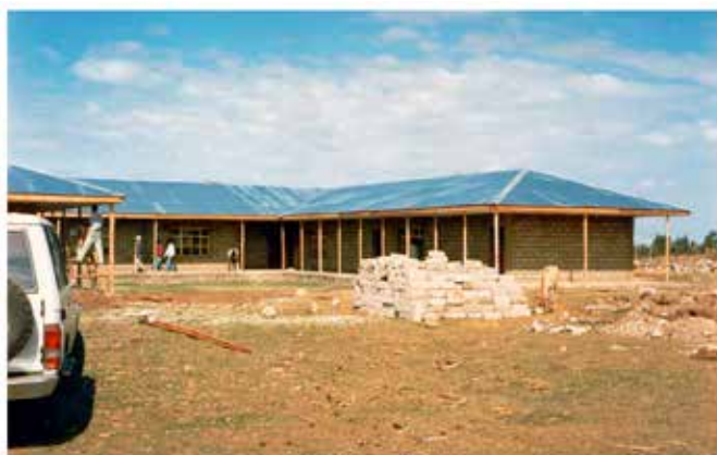
1993 Realizzazione di un asilo a Yeterek
