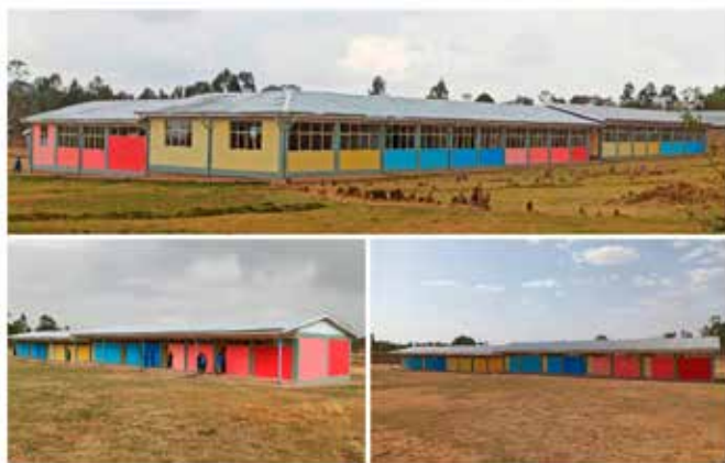
2019 Costruzione di una scuola elementare ad Abuna
