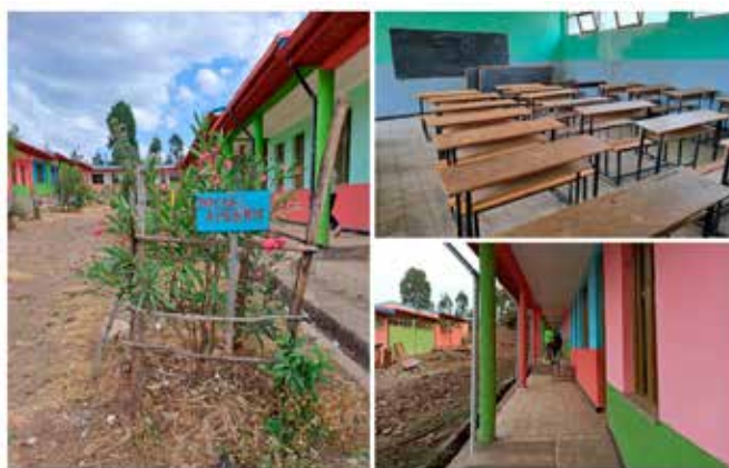
2022 In fase di realizzazione una scuola primaria a Shebraber
