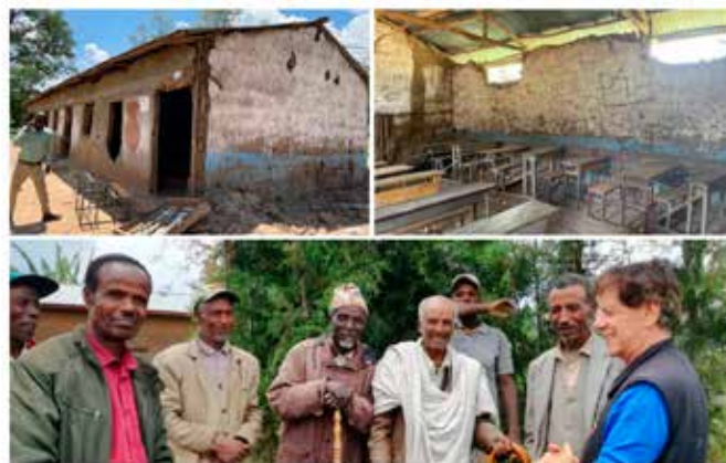
2023 A Gofa in fase di realizzazione una scuola primaria che sostituirà quella esistente
