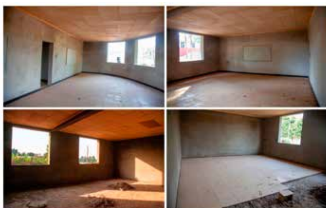
2022-2023 Lavori per la realizzazione di una scuola materna a Gunchure
