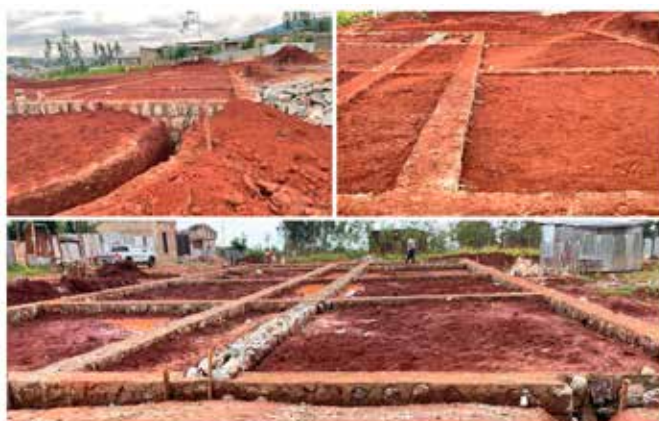
2023 Avviata la costruzione di una scuola materna a Soddo1 Kera
