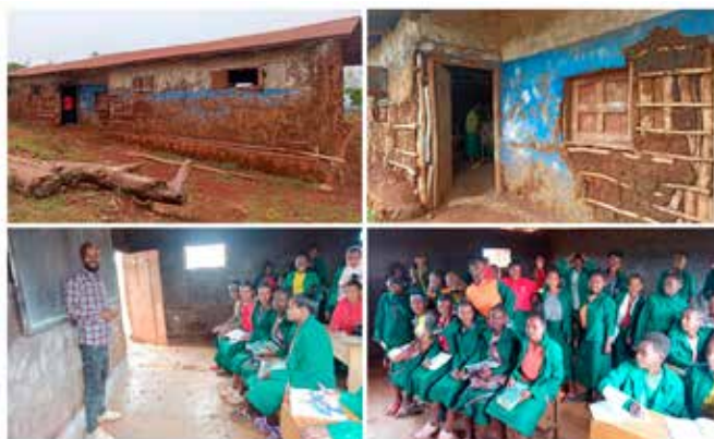
2022 In fase di realizzazione a Gale Hamos una scuola primaria che sostituirà quella esistente in condizioni fatiscenti
