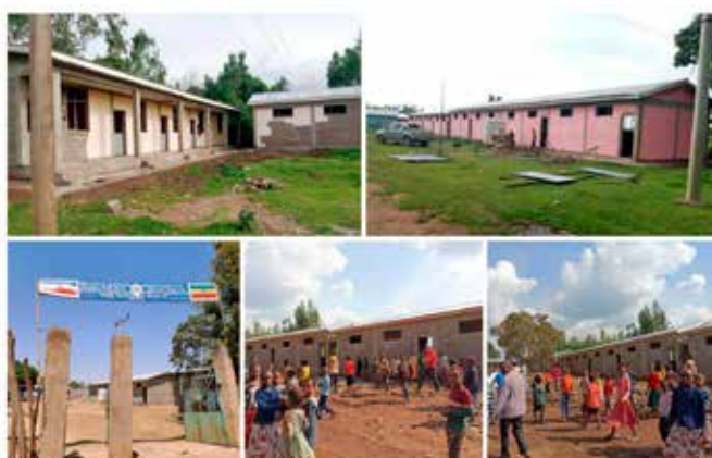
2022 La scuola primaria in costruzione a Sibaye Korke per 1.400 studenti
