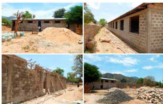
2023 Lavori per la realizzazione di una scuola primaria a Gofa
