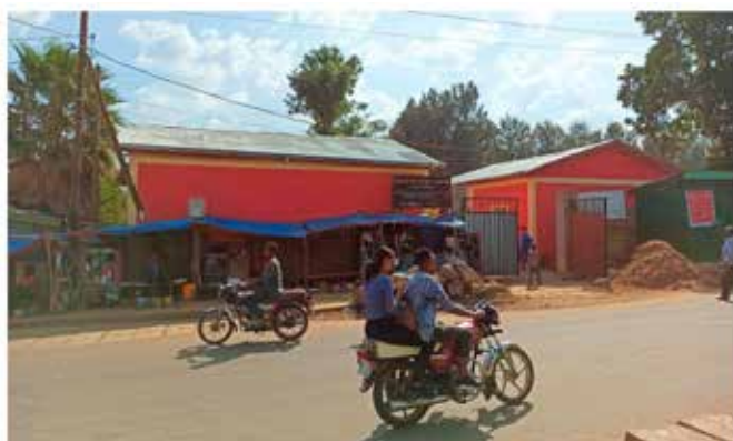
2022 Conclusa la costruzione e l'allestimento di una casa di accoglienza per mamme e bambini indigenti a Soddo
