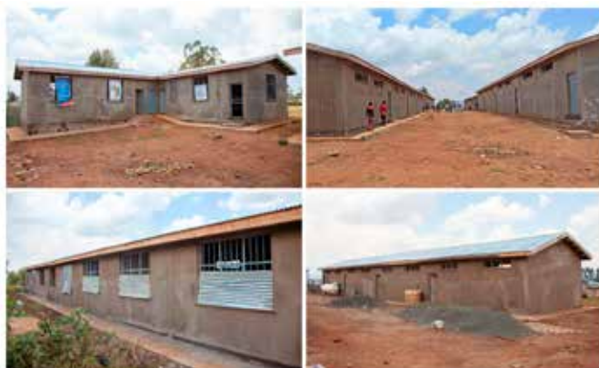
2022 In corso i lavori a Hossana per la costruzione e l'allestimento di una scuola primaria per 800 studenti
