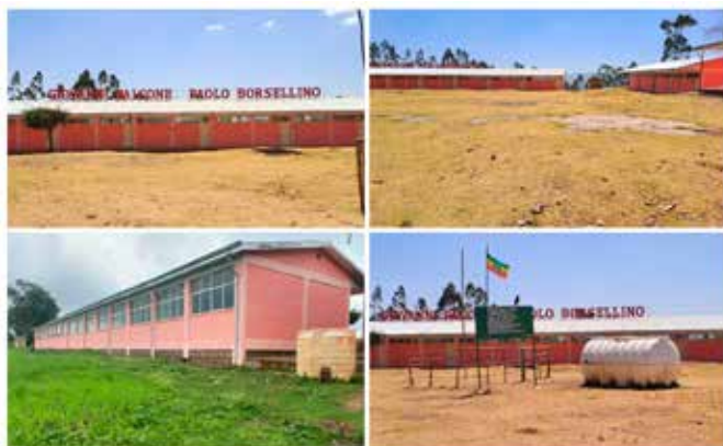
2021 Prossima alla conclusione la costruzione della scuola primaria Falcone e Borsellino a Berkoncio
