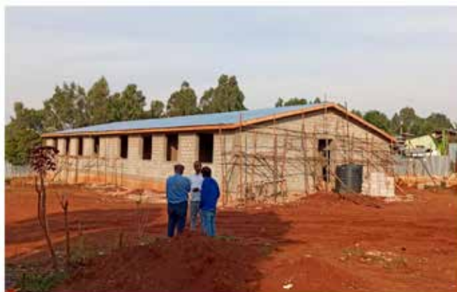
2022 Lavori per la realizzazione della scuola primaria a Gunchure
