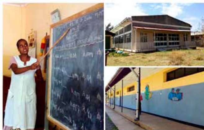
2016 A Wolisso costruzione di scuola primaria
